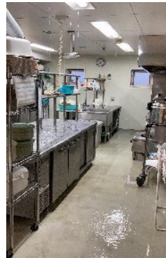
調理室（工事前）
